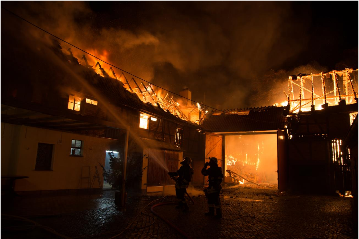
Am 26. Dezember 2014 zerstörte ein Großbrand einen Dreiseitenhof in Tonndorf (Landkreis Weimarer Land).
